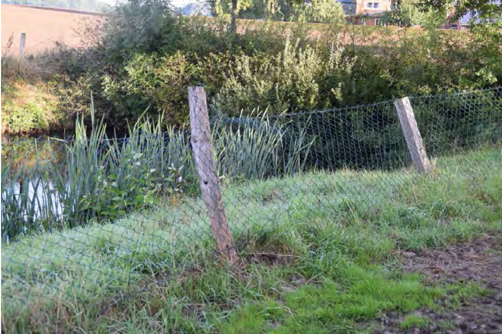
Feuerlöschteich Ehlersdorf, Richtung Steinwehr: Zaun defekt. Niedriger Wasserstand. Der BUA empfiehlt: Zaun reparieren/erneuern, Feuerlöschteich ausbaggern.
